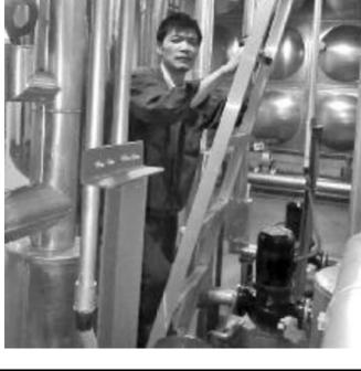
4月12日,门诊大楼B2楼空调机房有一根空调冷却水总管,在冷却塔清洗保养后,补水时发现有大量水漏出,由于该管道从23楼楼下到B2楼,漏水点正好靠近机房配电柜,如不及时处理就会造成配电柜进水,后果难以想象。吉晨物业工程部员工朱德华冒着闷热,难度大,具有危险性等爬进管道井内检查,该管道并没有踏梯,井内无光线,攀登只能沿着冷却水管往上爬,凭着他人熟练的技术,认真仔细负责的态度,从B2F一层一层排除爬到4F,查出了漏点,原因是一根直径500mm膨胀伸缩节破
