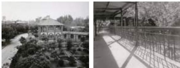
8舍,连接着左右7、9舍病房的风雨长廊,上世纪七十年代拆除
